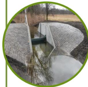
Um den Wasserstand im Ried zu erhöhen, wurden vorhandene Entwässerungsgräben verfüllt und die durchfließende Alte Wulbe mit einem stufenlos regelbaren **STAUWERK** versehen. Damit wird das mooreigene Quellwasser zurückgehalten und verbleibt länger in den Flächen. Der wiedervernässte
