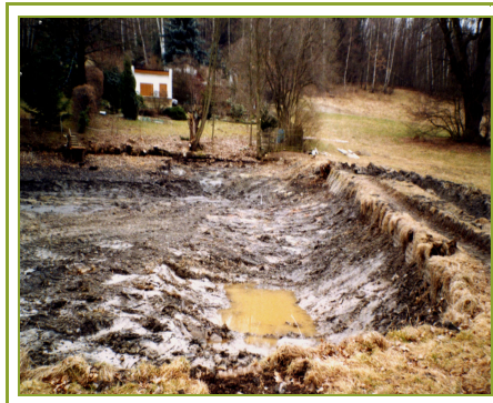
Rohzustand des Teiches nach der Entschlammung
