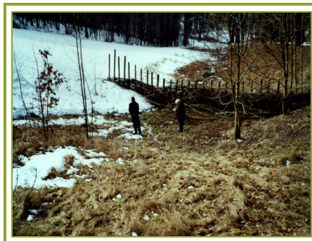
Flechtzaun als Schlammfang
