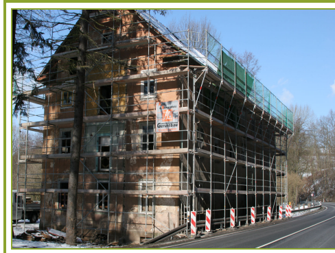
Anfang 2006 wurde das Dach repariert und Fenster und Türen "mardersicher" verschlossen
