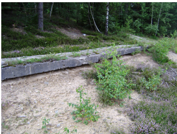
Unterspülter Kolonnenweg in der Görtdorfer Heide, 2011 instand gesetzt* (Foto: Beate Schrader)
