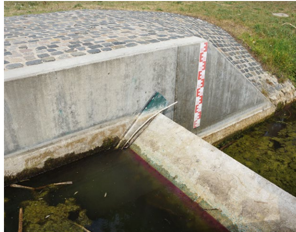
Das Wehr im Alperstedter Ried ist mangels Wasser ohne Funktion, die Stauhöhe liegt ca. 20 cm unter der üblichen Höhe, Foto: SNT
