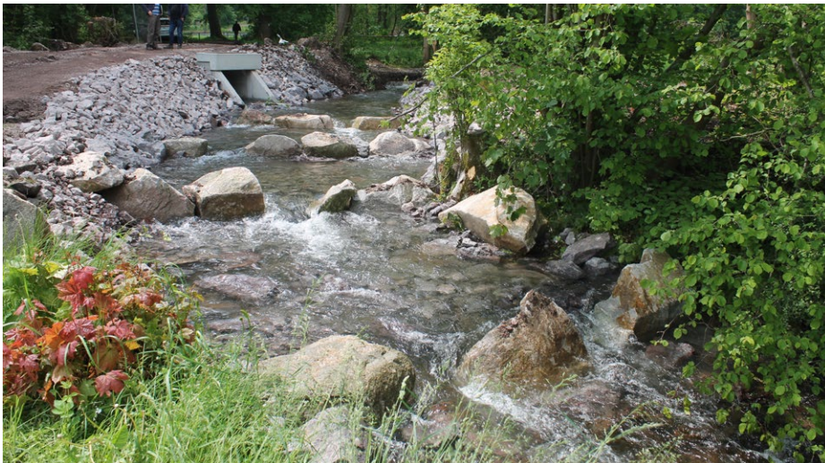
Nach der Maßnahme – Sohlgleite/Raugerinne statt Wehr, Foto: Naturstiftung David
