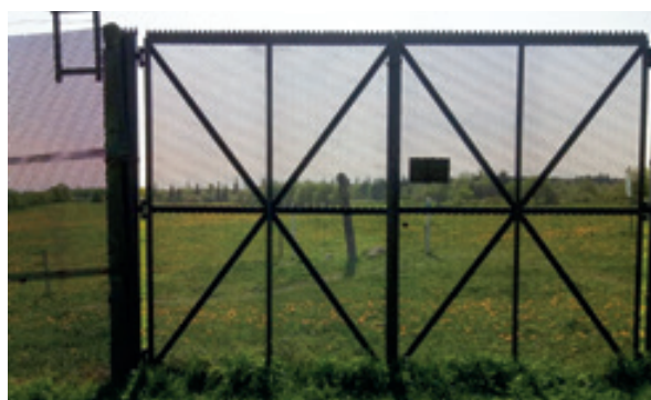
Sanierte Grenzanlage bei Frankenheim, Foto: Metallbau Beck GmbH
