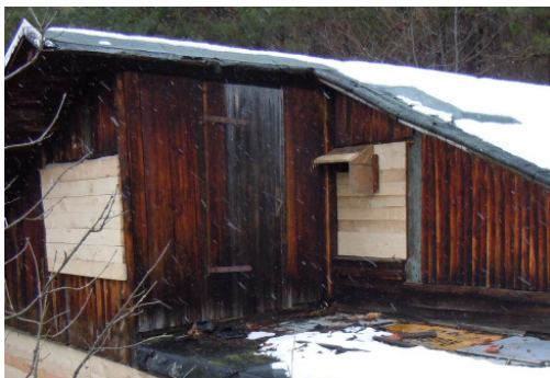
Bauliche Ausführung der neuen Einflugöffnung sowie neue Eingangsklappe Foto: Stiftung Fledermaus
