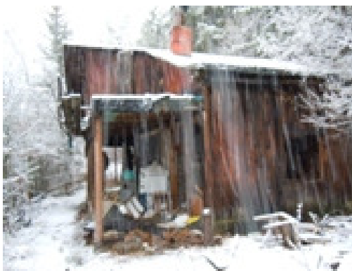
Wochenstubengebäude in westliche Richtung nach den Zerstörungen
